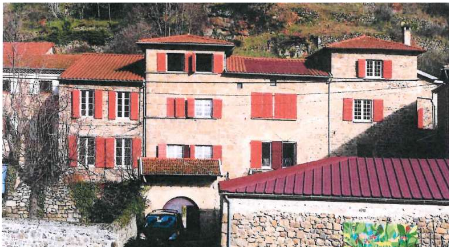
Figure 11 : Photographie de l'aspect extérieur d'un bâti avec l'insertion de panneaux photovoltaïques couleur terracota
