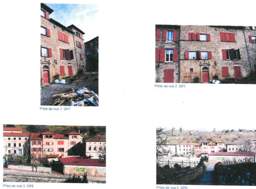
Figure 13 : Exemple 1- Prise de vue de l'environnement proche et lointain
